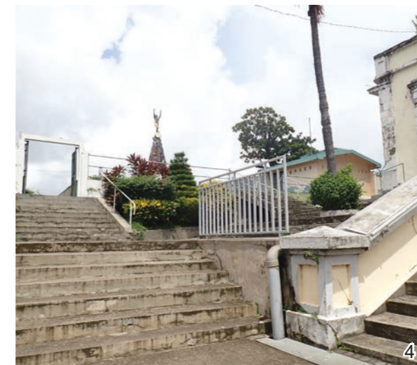
Escaliers anarchiques vers l'église et la place
