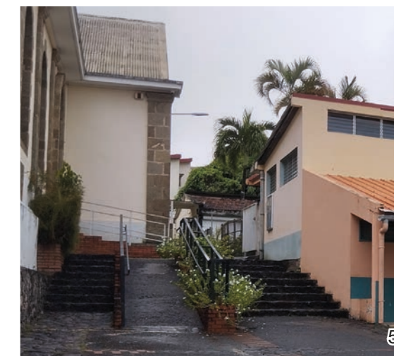
Accès pour les personnes à mobilité réduite
