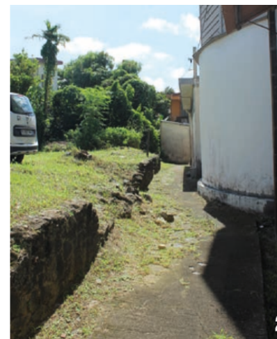
Muret face à l'arrière de l'église
