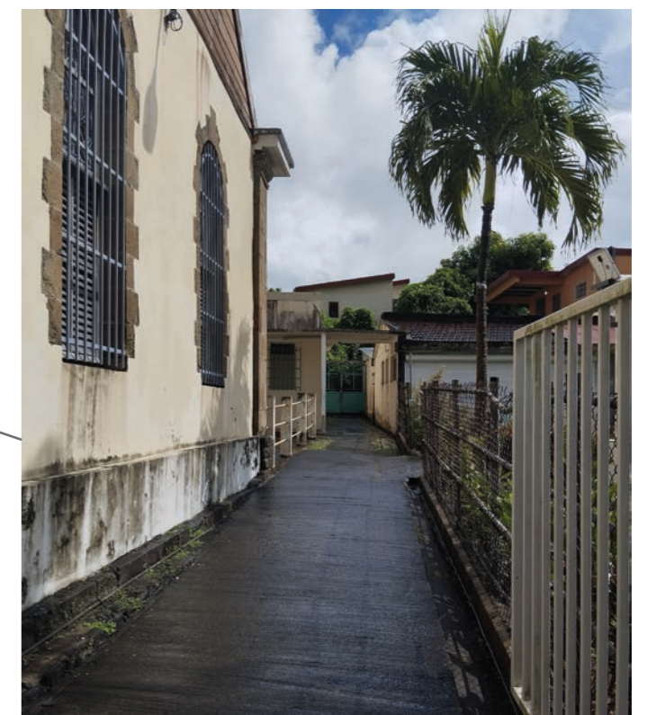
Passage latéral privatisé par deux portails
