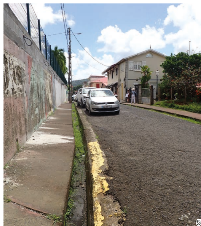
Mur de soutènement de la dalle sur la rue Capitaine Pierre-Rose. Le trottoir étroit est bordé d'un caniveau.
