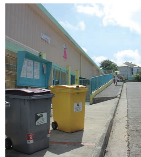
Façade sur la rue de la Crèche vers la cantine
