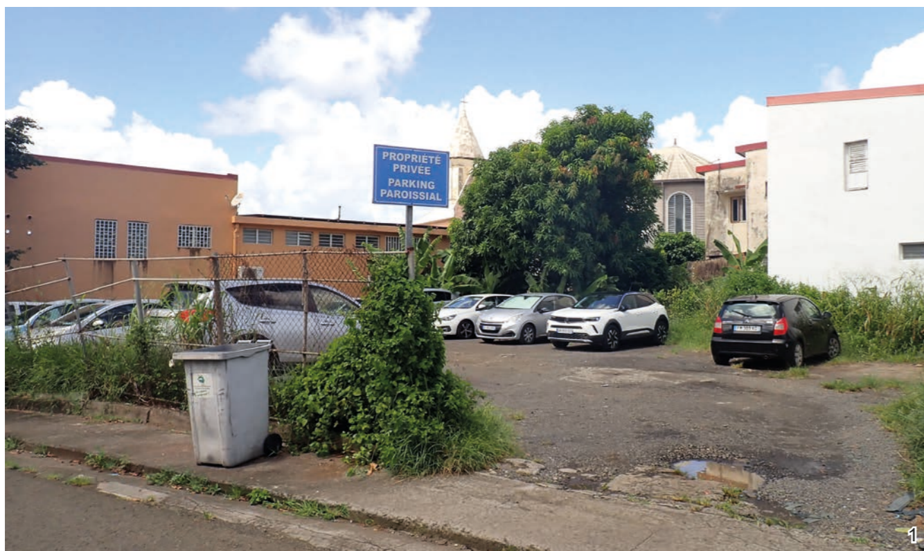
1 L'espace non bâti laisse voir l'église. Les grillages laissent passer le regard mais sont dégradés. Le revêtement de sol est dégradé.
