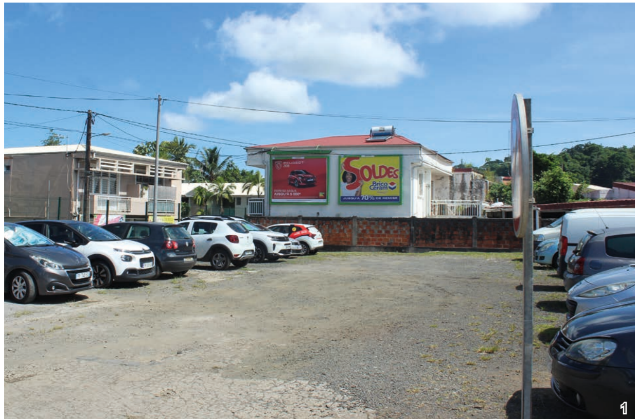
Parking minéral au revêtement dégradé, grands panneaux publicitaires inesthétiques
