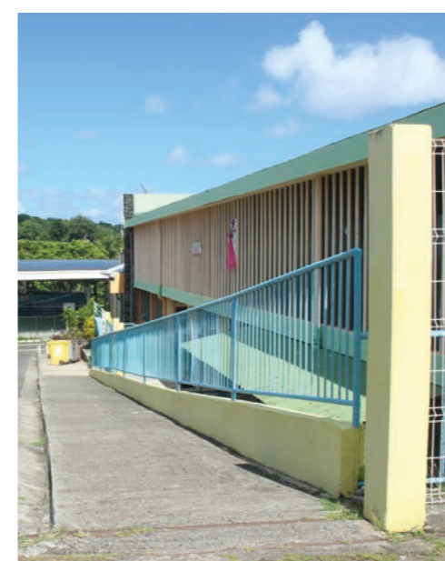
Façade sur la rue de la Crèche depuis l'espace de parking
