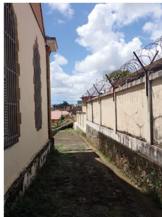
Mur de l'école sur la rue de l'Église
