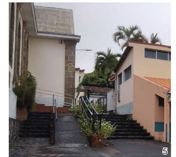
Accès pour les personnes à mobilité réduite
