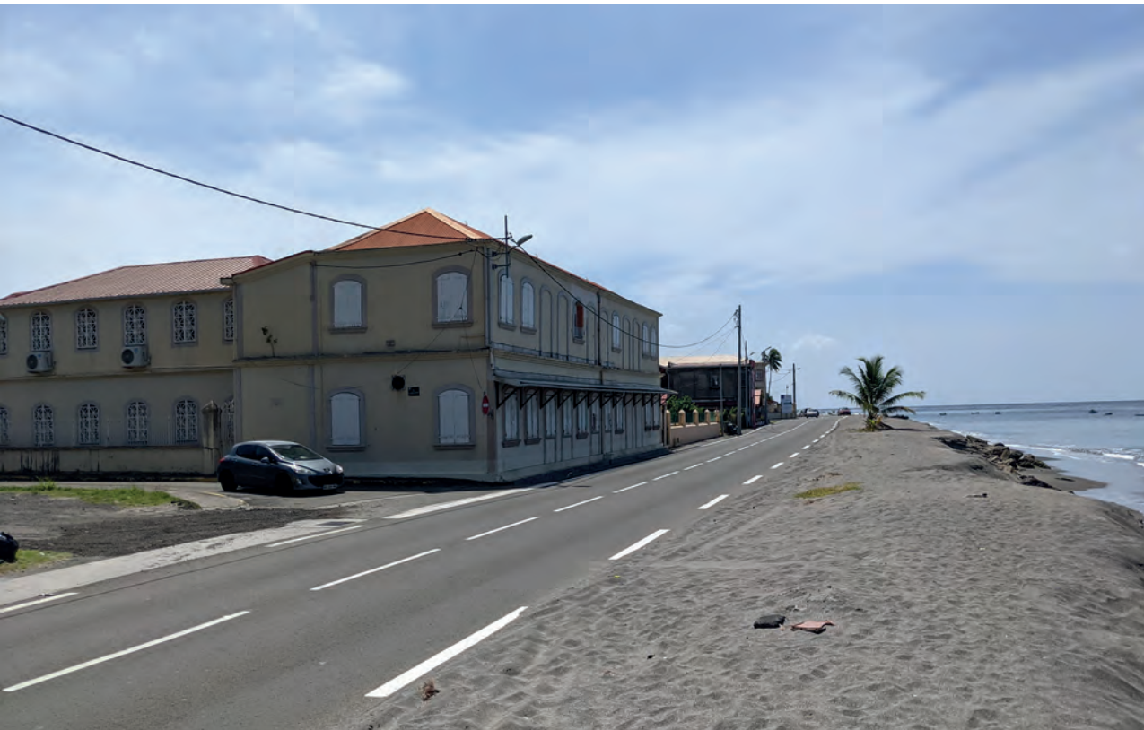
RN2, annexe collège - Novembre 2021
