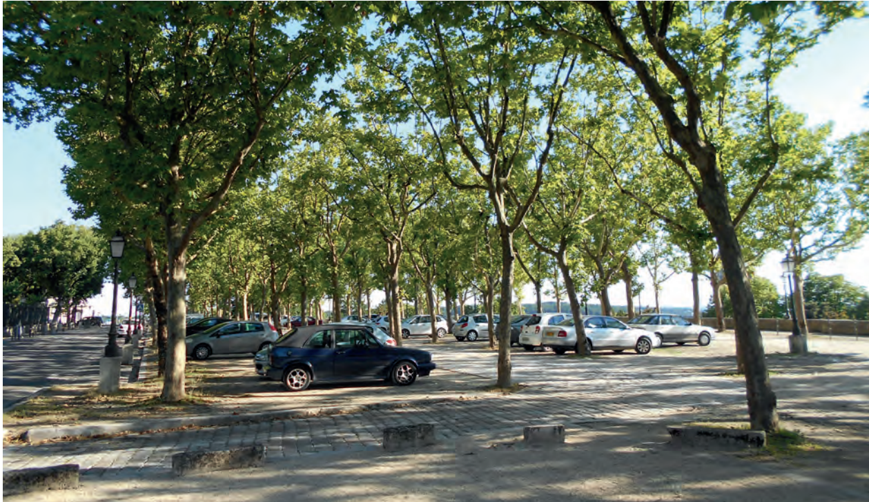
Parking végétalisé et non imperméabilisé à Angoulême (photo ADDUAM)
