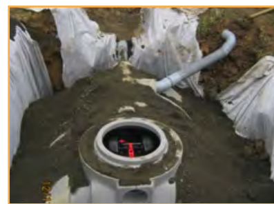
L'installation du système est très rapide : en moins d'une journée, la fosse septique ainsi que le traitement par filtre à coco sont installés et prêts à l'emploi. (photos P. Lanes)
