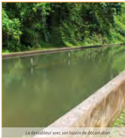
Le captage... L'ouvrage est situé sur les rivières Capot et Falaise mais seule l'eau de la Capot est captée. En effet, l'eau de la rivière Falaise est souvent très turbide du fait de la présence de carrière en amont.
