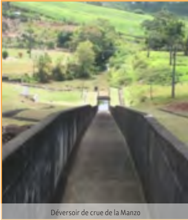
Déversoir de crue de la Manzo
