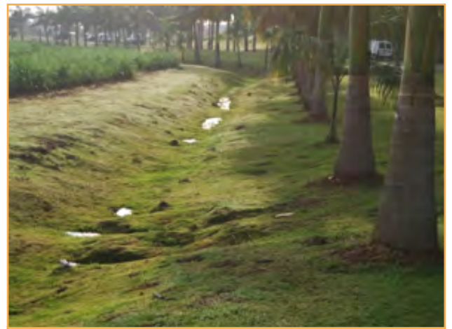
Les noes situées en entrée de ville du François drainent l'ensemble du secteur et ont également un intérêt paysager qui participe à la qualité urbaine de cette entrée de ville.
