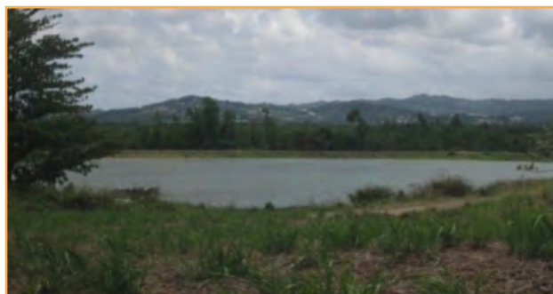
Une retenue collinaire de Château Gaillard aux Trois-îlets
