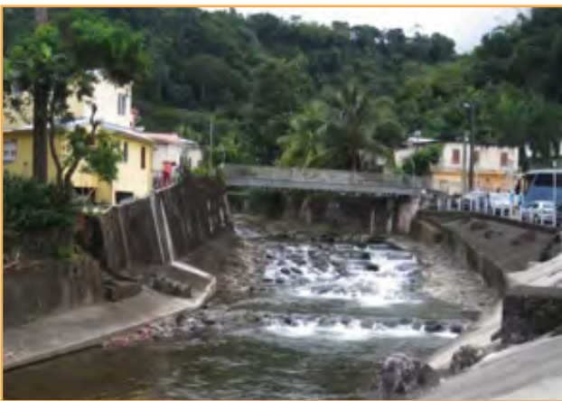
La Grande Rivière, à proximité de son embouchure (commune de Grand' Rivière). Cette rivière a été canalisée en aval, où elle traverse une zone densément habitée.
