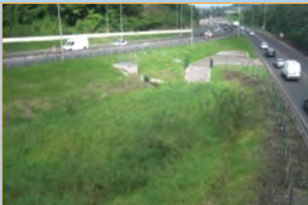
Bassin de rétention d'eau au Lamentin (échangeur sur la RN5)
