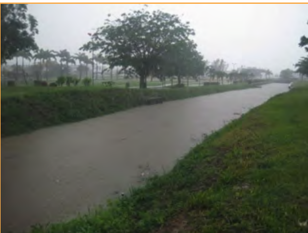
Les noes du Lamentin, quartier Place d'Armes, jouent pleinement leur rôle en période de pluies. Cependant, en cas de fortes pluies, elles présentent des limites : l'eau déborde dans la zone commerciale limitrophe et recouvre la chaussée. L'importante imperméabilisation de tout le secteur mais aussi en amont du bassin versant sont les raisons de ces crues très impressionnantes.
