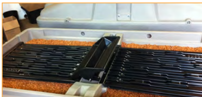
Filtre et intérieur du filtre, comprenant le système de distribution et les plaques d'alimentation, ainsi que les copeaux de coco. Les effluents prétraités sont répartis de manière uniforme sur le filtre grâce à une bascule (au centre de la photo de droite). Le mécanisme est installé au sommet de l'installation. Les effluents vont être filtrés grâce à la percolation dans les copeaux de coco. Photo P. Lanes
