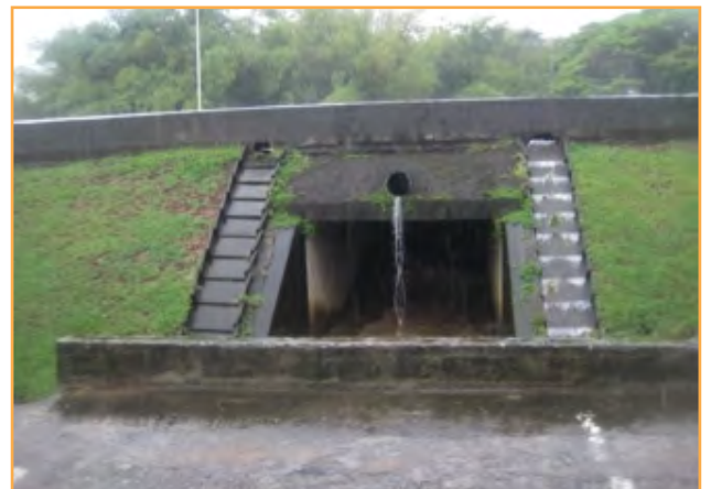
Ouvrage hydraulique sous la RN1 au niveau de la zone d'activités de la Jambette au Lamentin. L'eau de pluie qui tombe sur la route est évacuée via cet ouvrage situé aux extrémités de la chaussée dans un canal qui recueille toutes les eaux pluviales, avant de retourner dans le milieu naturel... sans être traitées. Les eaux de ruissellement, au contact de la route, se chargent de polluants divers.
