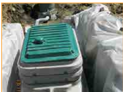
L'installation du système est très rapide : en moins d'une journée, la fosse septique ainsi que le traitement par filtre à coco sont installés et prêts à l'emploi. (photos P. Lanes)
