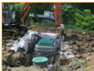
Installation d'un système d'épuration à filtre à coco
