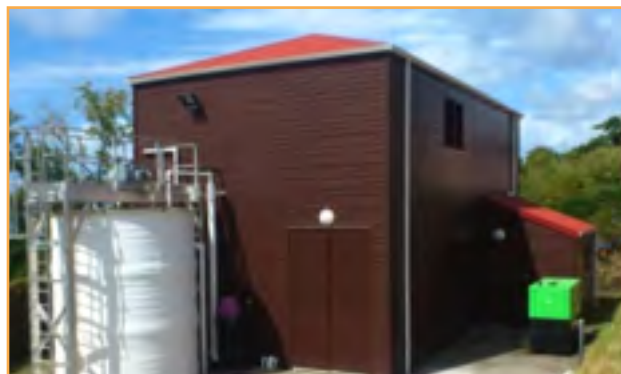
Station d'épuration à boues activées avec clarification membranaire (capacité 450 EH) à l'Anse Dufour (Anses d'Arlet)
