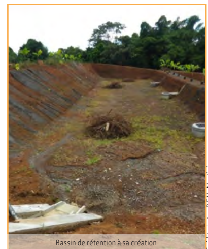
Bassin de rétention à sa création
